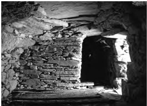
Avise. Baraques du Fond. Voûte en encorbellement
