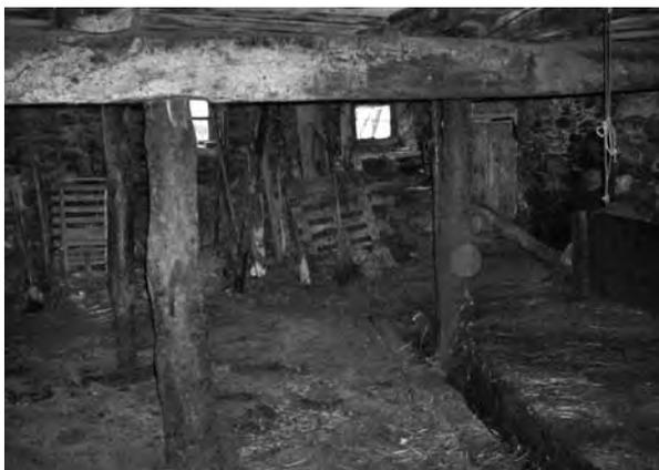
Les étables traditionnelles plus grandes se caractérisent par la présence d'un *tra badzàn*, c'est à dire une poutre traversant le plafond transversalement par rapport aux autres, et de *colenne*, des colonnes ayant la fonction de soutien.
